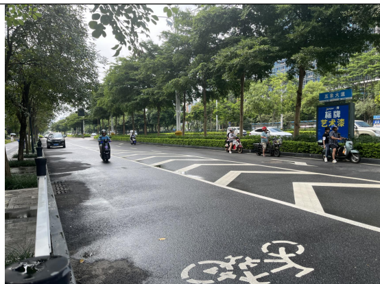
2024 年 8 月道路工程区现状情况 (起点建设路)
