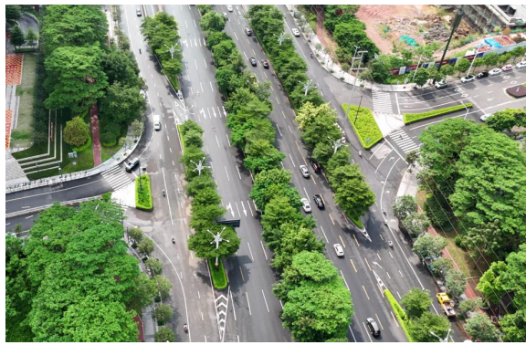
2024年8月道路工程区现状情况（桩号 K12+065）
