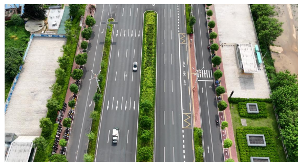
2024 年 8 月道路工程区现状情况 (桩号 K6+755.758)
