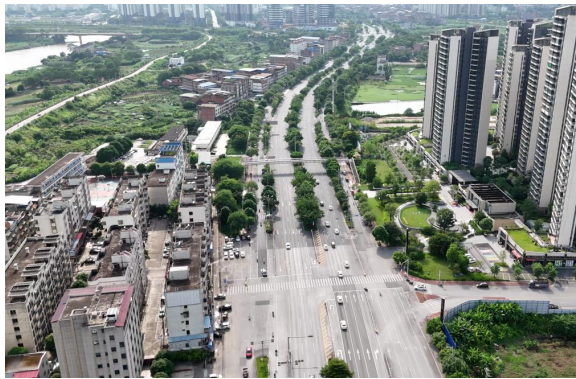
2024年8月道路工程区现状情况（终点龙 岗大道）
