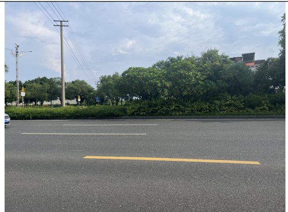
2024年8月道路工程区现状情况（终点龙 岗大道）
