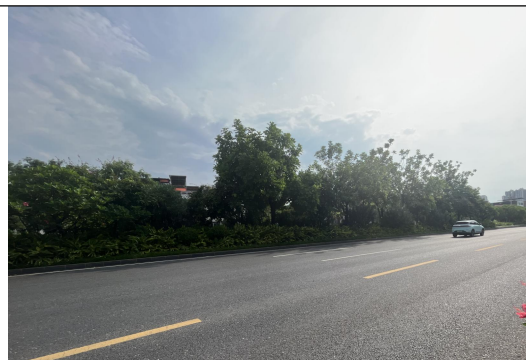
2024 年 8 月道路工程区现状情况 (桩号 K6+755.758)
