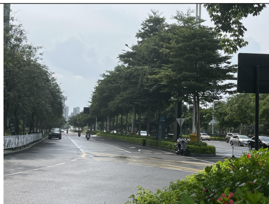
2024 年 8 月道路工程区现状情况 (桩号 K8+258)
