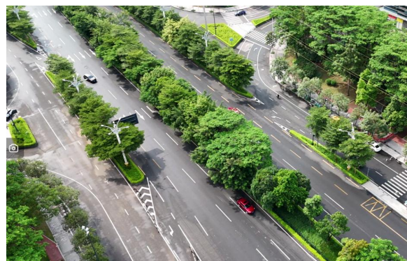
2024 年 8 月道路工程区现状情况 (桩号 K8+258)
