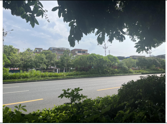
2024年8月道路工程区现状情况（桩号 K11+500）
