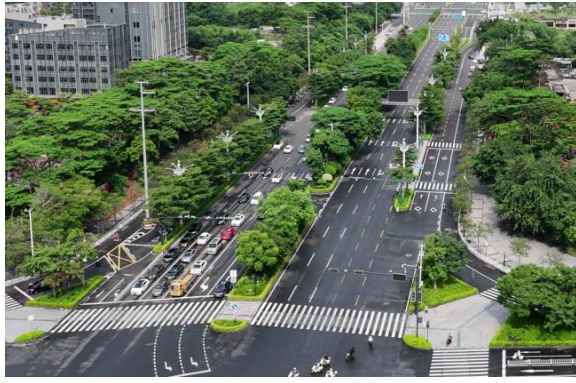
2024年8月道路工程区现状情况（桩号 K11+500）
