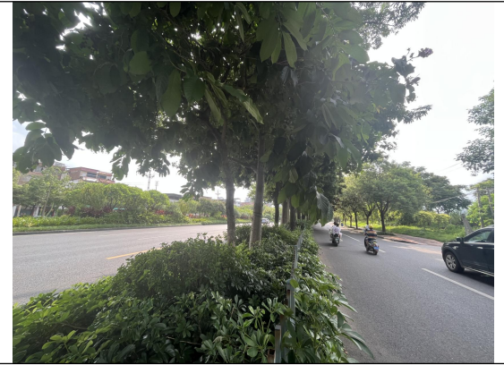
2024年8月道路工程区现状情况（桩号 K12+065）
